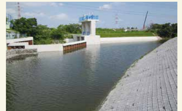
準用河川延命寺川の護岸整備
