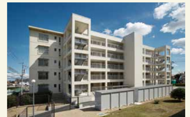
殿ノ前住宅(エレベーター設置)
