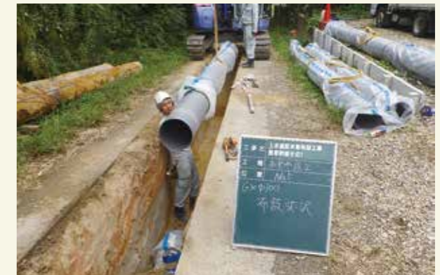
耐震化工事の様子
