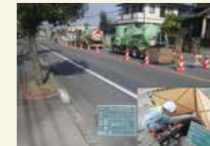
カメラによる管内調査の様子
