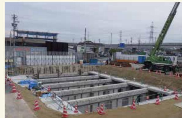
六間調整池整備工事の様子
