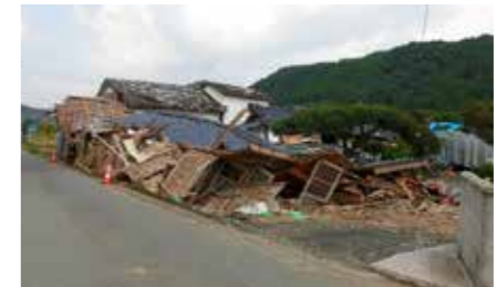
熊本地震(熊本県益城町)
