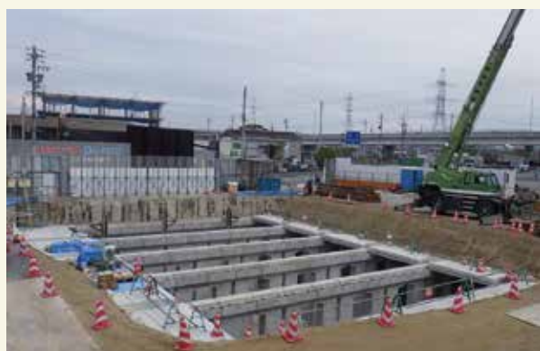
六間調整池整備工事の様子
