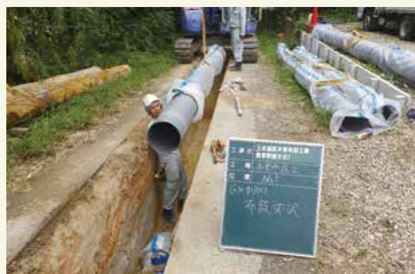
耐震化工事の様子
