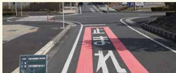
路面標示強化（柵山町地内）
