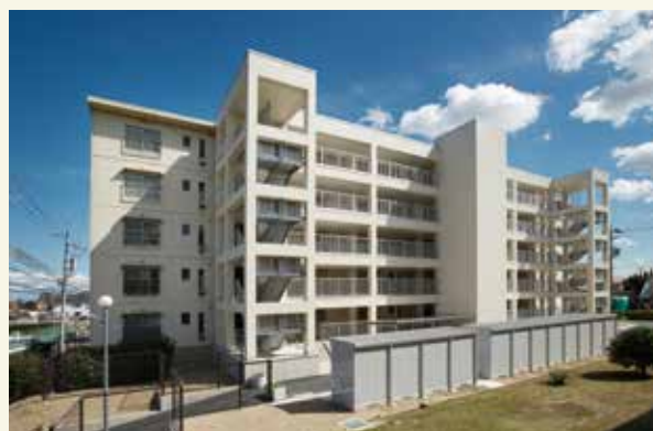
殿ノ前住宅（エレベーター設置）
