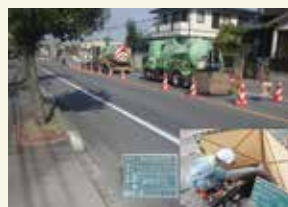
カメラによる管内調査の様子
