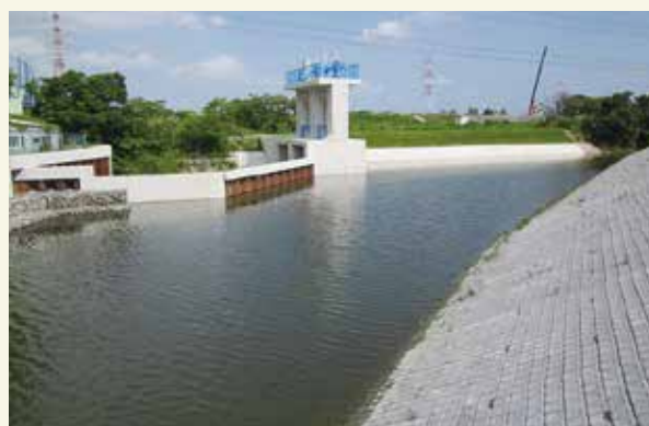
準用河川延命寺川の護岸整備
