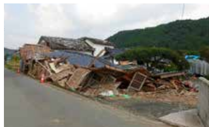
熊本地震(熊本県益城町)
