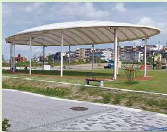
防災トイレ用のマンホールも備えています。
