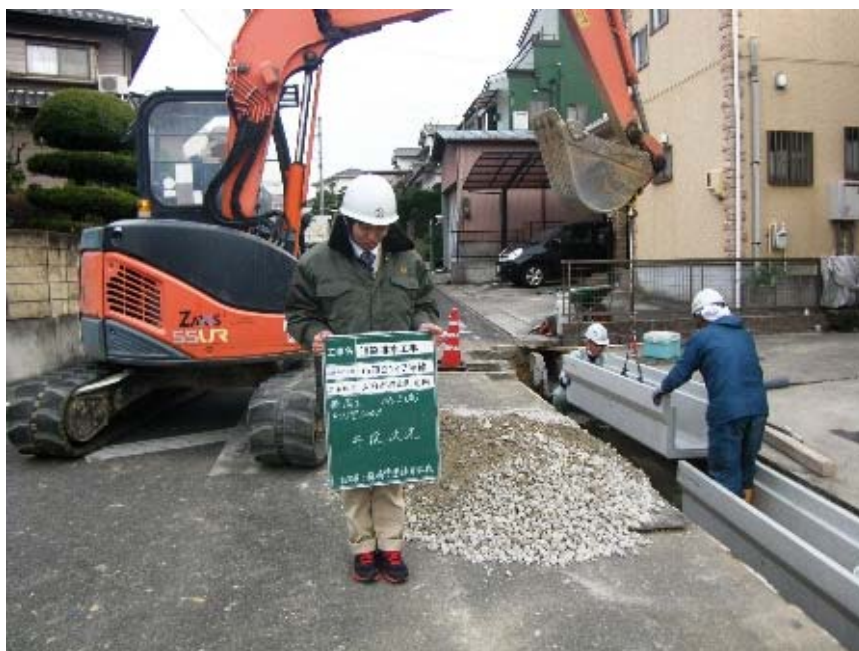
写真：側溝改良工事状況
