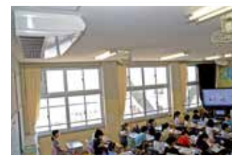
小中学校普通教室、 特別支援教室の空調設備設置
