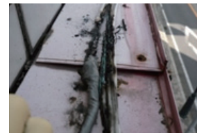
周辺機器（※）の劣化、破損 ※分電盤、配線、変圧器（トランス）、スイッチ等
