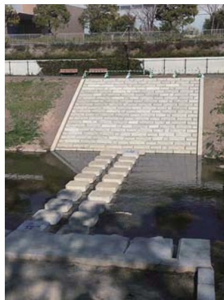
▲鞍流瀬川に設置した飛び石
