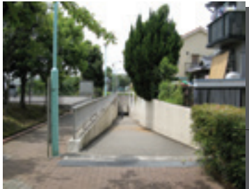
堀越地下人行道
