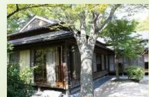
大倉公園休憩棟
