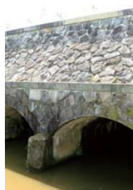
▼明神樋門、明神川逆水樋門、国登録有形文化財へ
