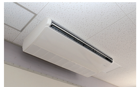
小・中学校空調整備
