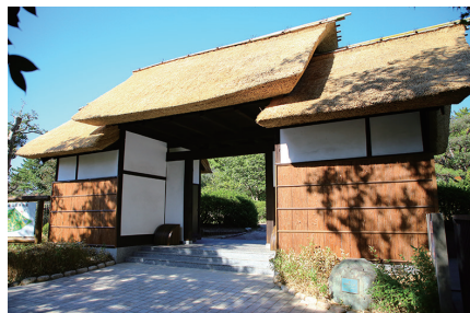
大倉公園の改修
