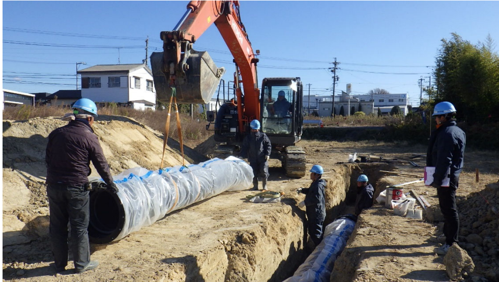
配水管布設工事
