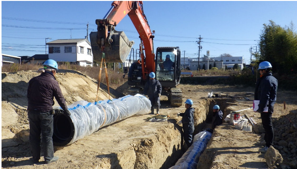
配水管布設工事
