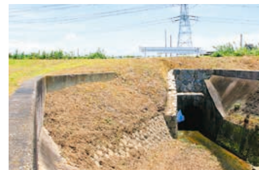
明神川逆水樋門／令和3年に国の登録有形文化財に登録。明神樋門同様に、人造石工法で築いた壁体を重ねている。近代土木遺産の一つ。
