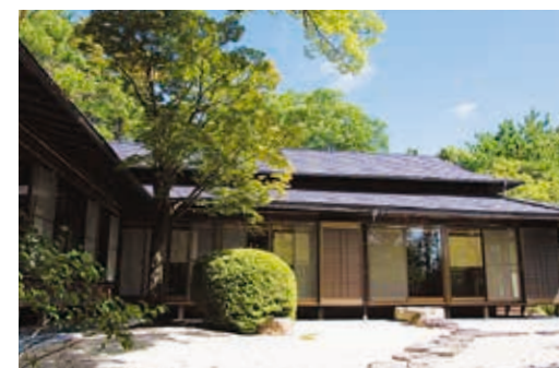
大倉公園休憩棟／平成27年に国の登録有形文化財に登録。庭に面した4つの和室が2室連なるL字型。太平洋戦争中に造られた鉄筋コンクリート造の防空壕が現存している。
