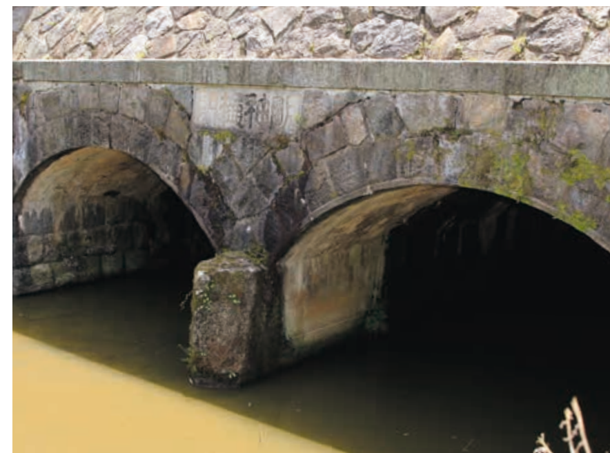
明神樋門／令和3年に国の登録有形文化財に登録。樋門とは川や排水路の堤防を交差するトンネルのことで大きな川から逆流する水を止める役割を果たしている。明神川と五箇村川を立体交差させるために設けられた貴重な史跡。
