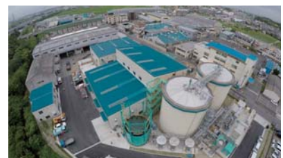
▲横根バイオガス発電施設(横根町)
