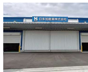
第二工場外観
