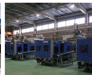
第二工場成形工程
