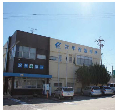
大府本社工場外観
