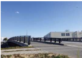
道路橋新設工事 現場写真
