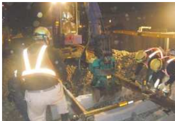
【マクラギ更换】 地震対策用マクラギに更换する作業
