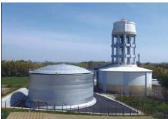
2018年度完成(写真左側) 大府市水道事業発注 長草配水場
