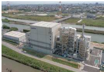
リサイクルプラント東浦工場
