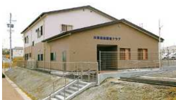
放課後クラブ専用棟新築工事(2015年完成)
