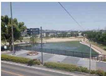
親水空間整備工事(池)【2021年完成】
