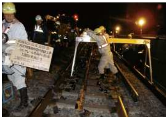
【レール更换】レールを新しく更换する作業
