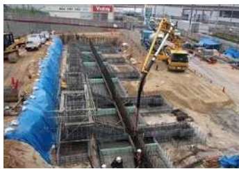
店舗や施設の基礎工事
