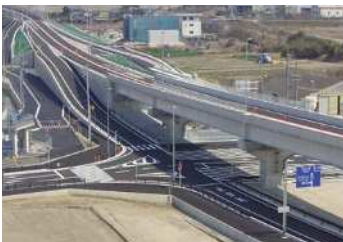
2013年度完成 知多建設事務所発注 一般国道366号線
