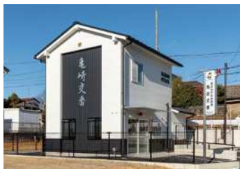
建築 半田亀崎交番建設工事
