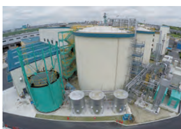
バイオガス発電施設(横根町)
