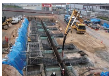
店舗や施設の基礎工事
