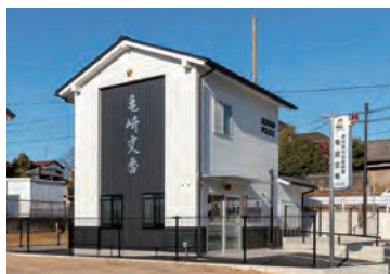
建築 半田亀崎交番建設工事
