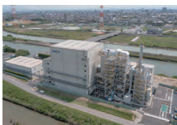
リサイクルプラント東浦工場
