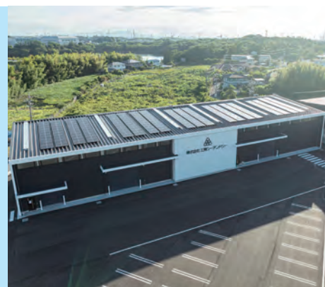
三恵シーアンドシー 工場棟
