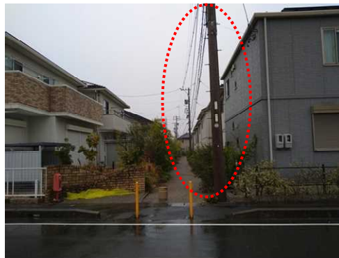
裏配線により無電柱化された住宅街（一屋町）
