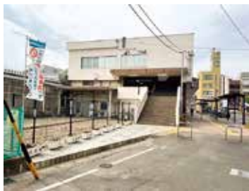
▲JR大府駅東口多目的スペース予定地
