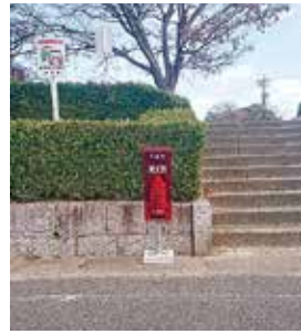
▲初期消火の要 街頭消火器
