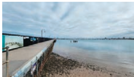
▲建て替え中のセント・キルダの桟橋
