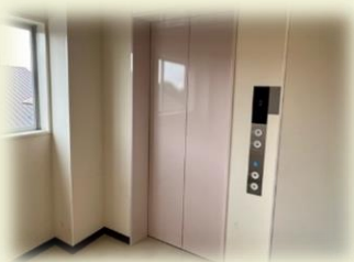
エレベーターの設置
