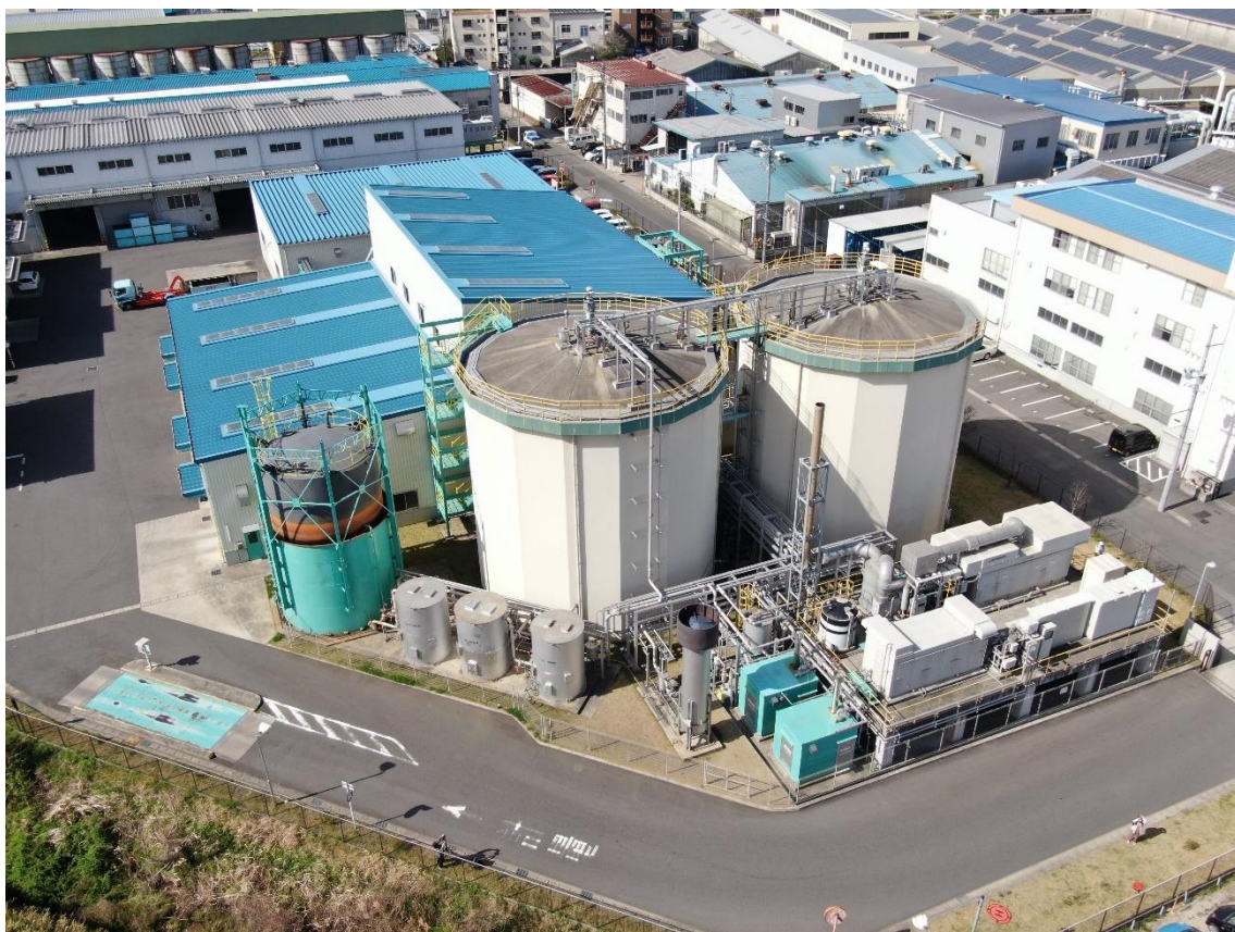
横根バイオガス発電施設（上空から）
