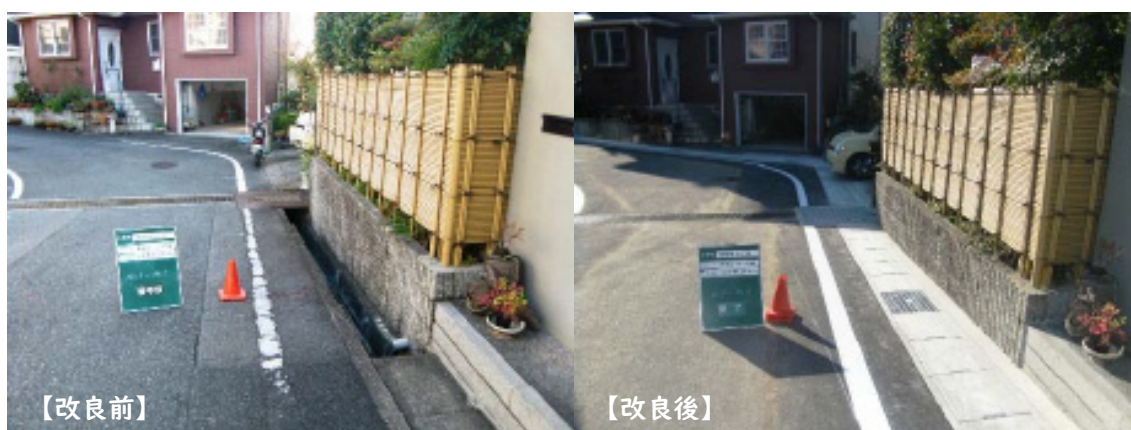
図表 5-3 側溝改良の様子
