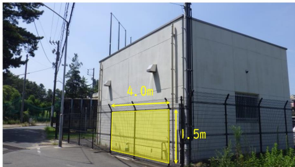
写真①：フェンス外周（東側）
