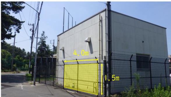
写真① : フェンス外周 (東側)
