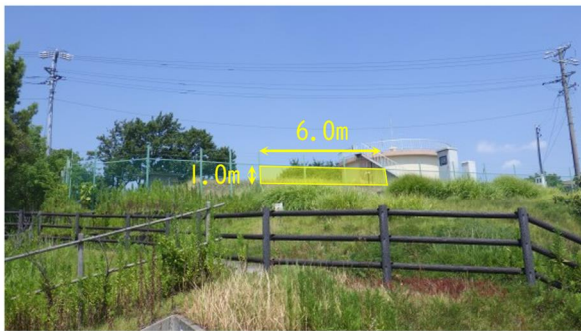
写真①: フェンス外周 (東側)
