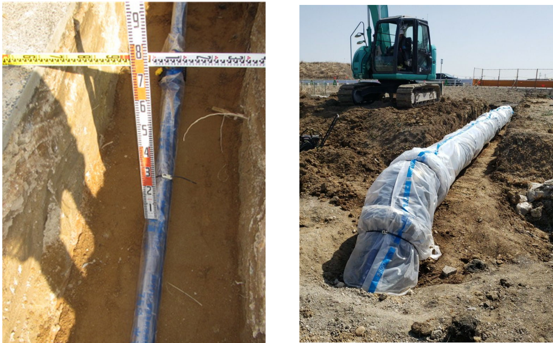
配水管布設工事
