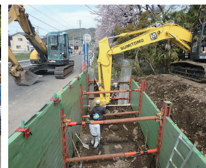
水路集水樹布設工事
