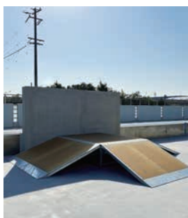
▲コンクリートの壁が立つスケートパークおおぶのセクション
